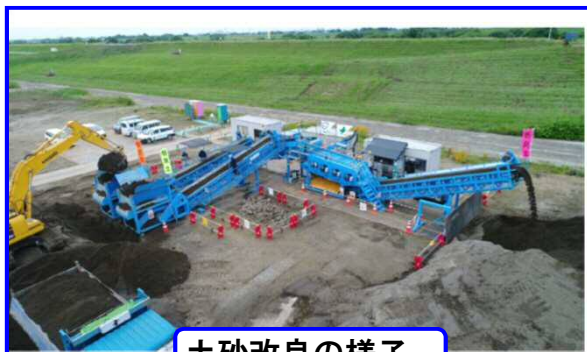
土砂改良の様子
