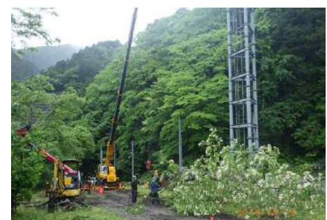
〔工事用道路工事 ・仮設プラントヤード造成準備〕
