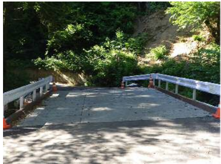
〔工事用道路工事・林道仮橋〕
