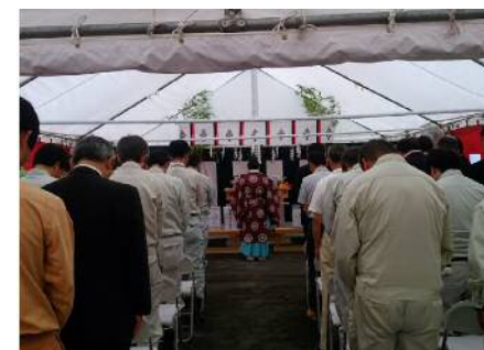
〔工事用道路工事・安全祈願祭〕
