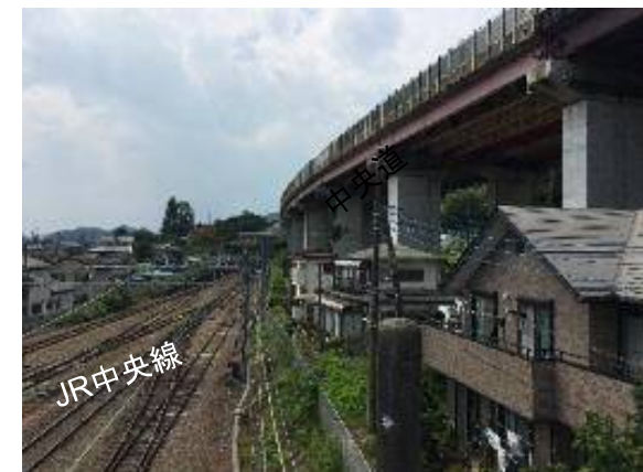
〔 対策を実施する相模湖高架橋 〕
