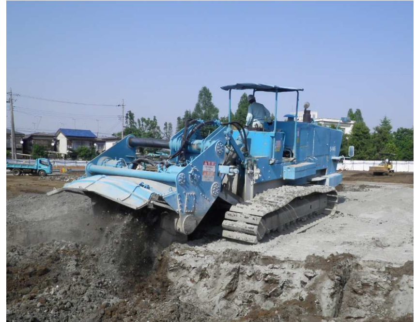
地盤改良工施工機械イメージ
