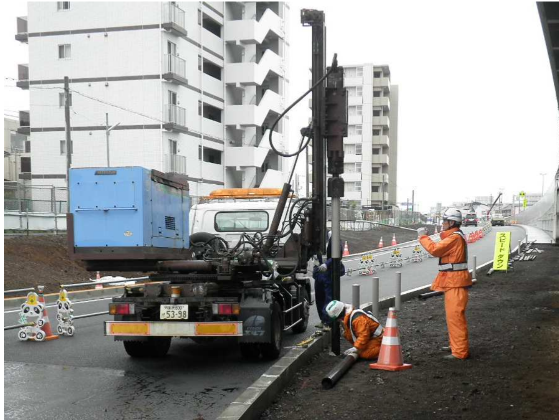
防護柵支柱施工イメージ
