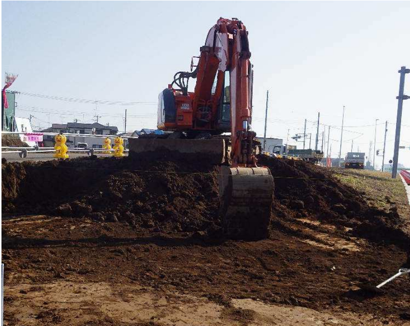
土工施工機械イメージ
