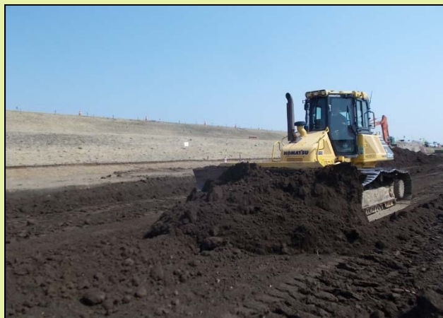
MCブルドーザによるICT施工
