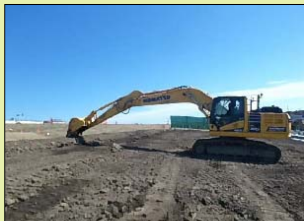
MCバックホウによるICT施工
