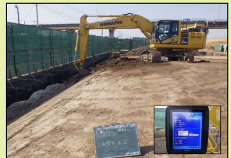
ICT施工 (バックホウ)
