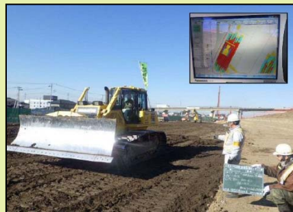
ICT施工 (ブルドーザ)
