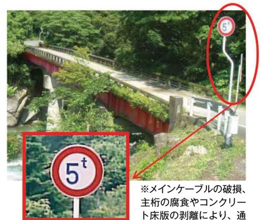
※メインケーブルの破損、主桁の腐食やコンクリート床版の剥離により、通行規制を通行規制を実施している事例
