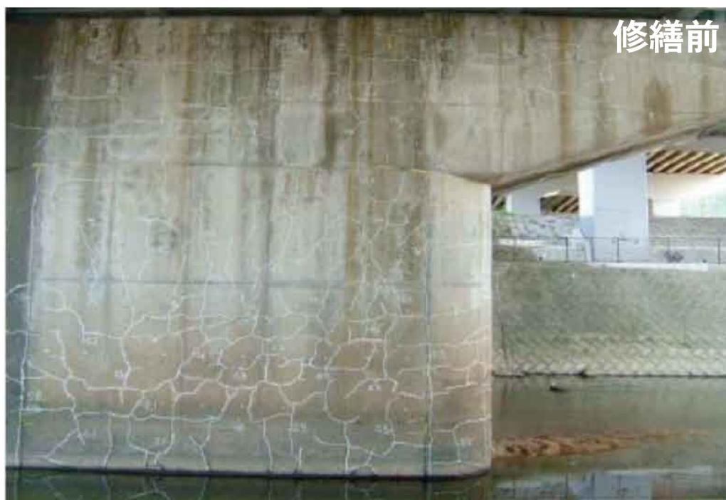
アルカリ骨材反応によりひび割れが発生
