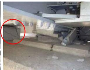
写真-6 支承の破損の状況
