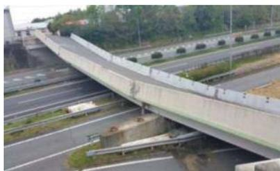
写真-2 横変位拘束構造の破壊、落橋 (県道小川嘉島線・府領第一橋)
