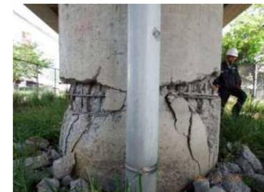
写真-7 段落し部の損傷
