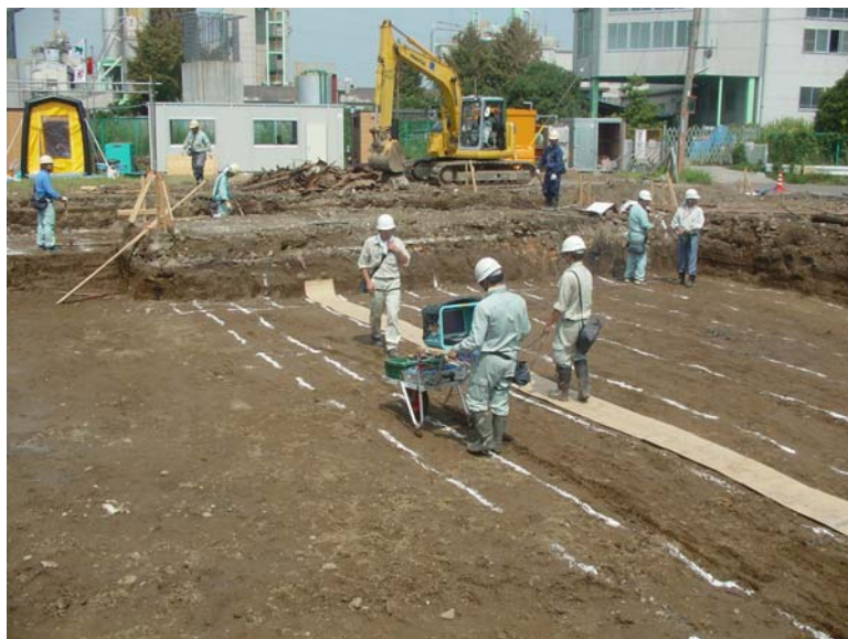
GPR探査状況
