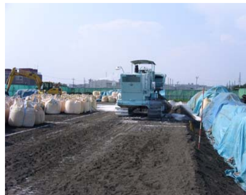
⑤ 土壌改良(消石灰混合)
