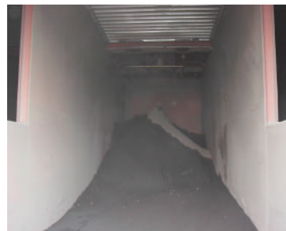
処理済土壌保管室
