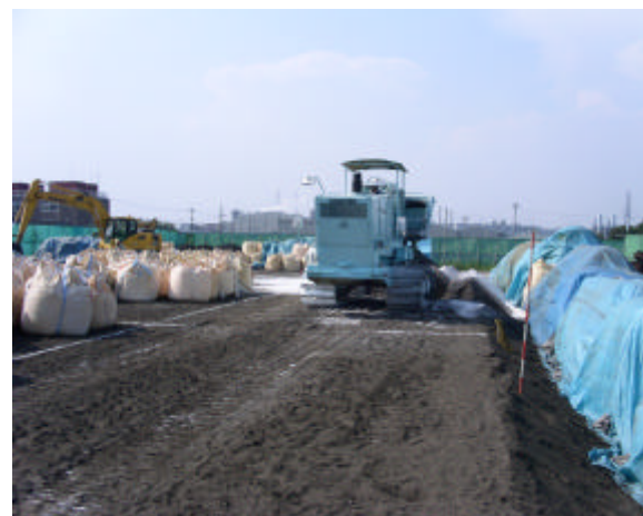
土壌改良 (消石灰混合)
