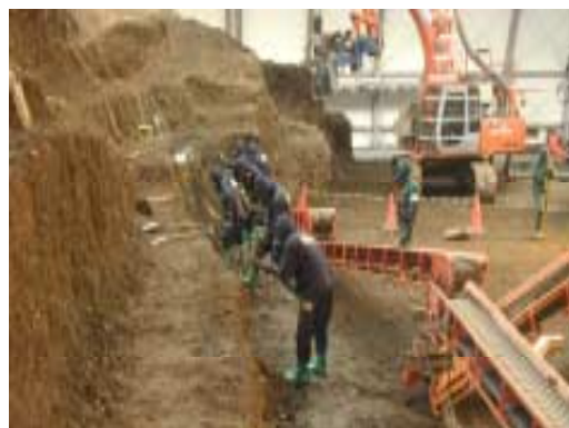
人力掘削・移送の状況
