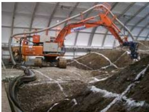
機械掘削・吸引の状況
