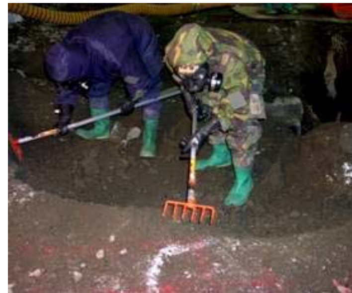
掘削調査の状況
