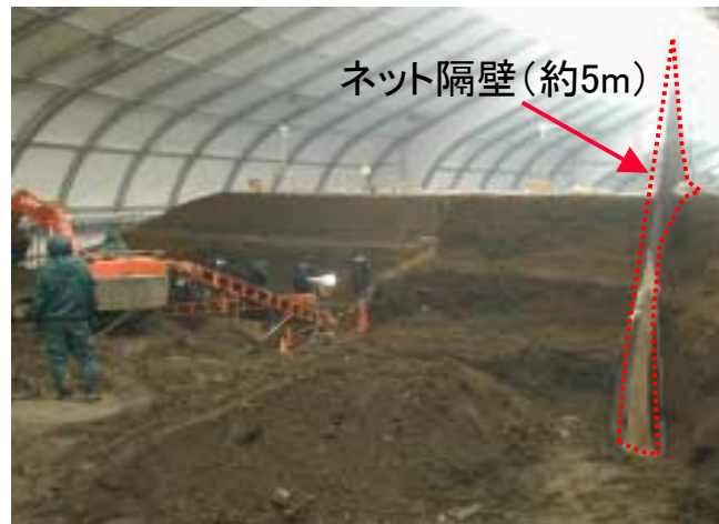
②作業場所の分離 (ネット状の隔壁:高さ約5m)
