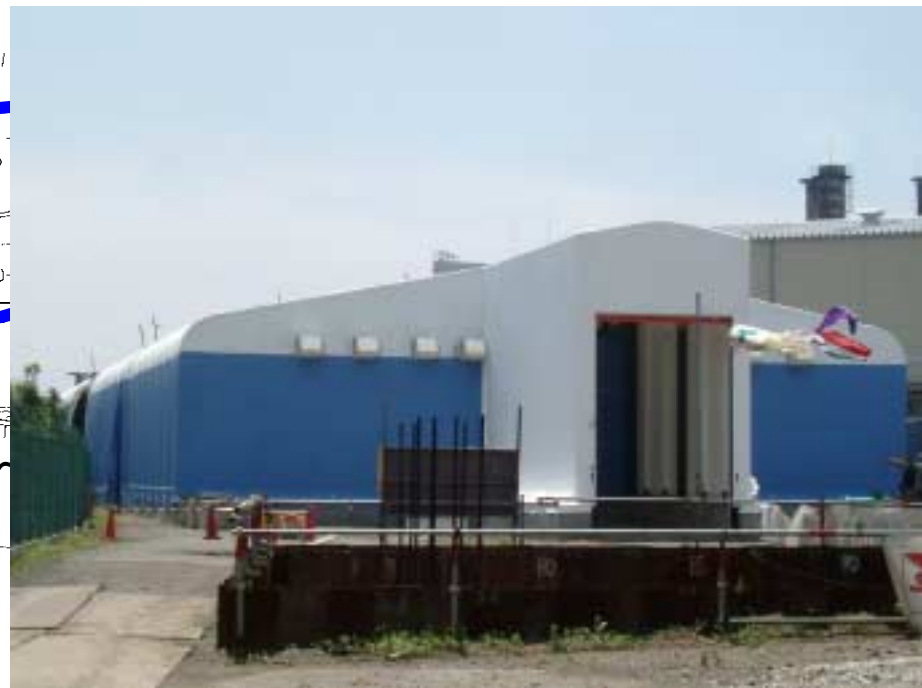
テント(P29～P30区間)の状況
