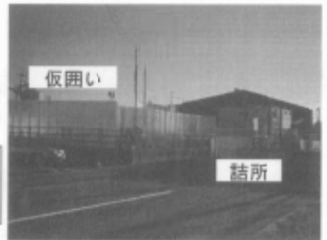
橋脚工事現場 北出入口
