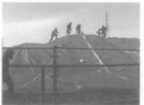
掘削残土仮置き場 シート被覆
