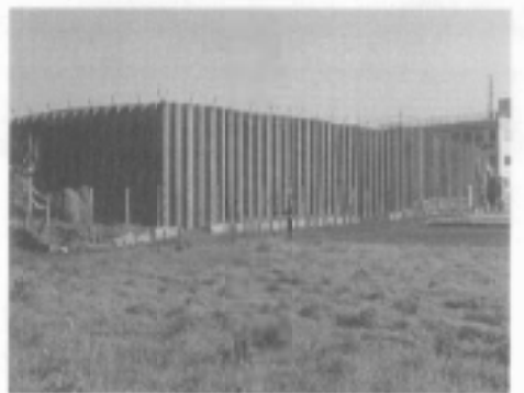
掘削残土仮置き場 仮囲い
