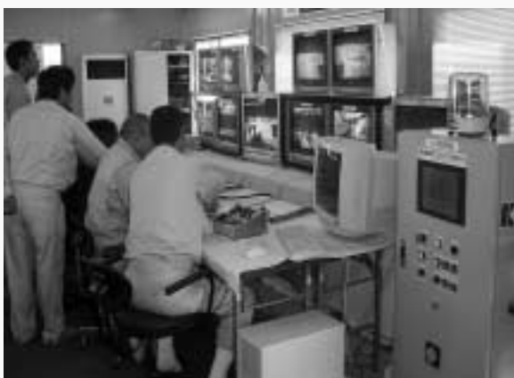
分離作業(遠隔操作の状況)
