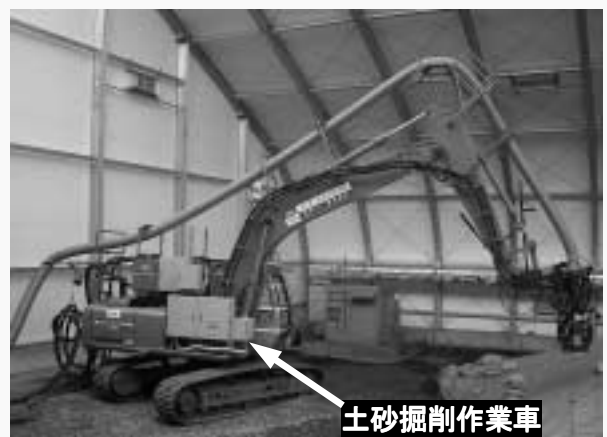
分離作業状況
