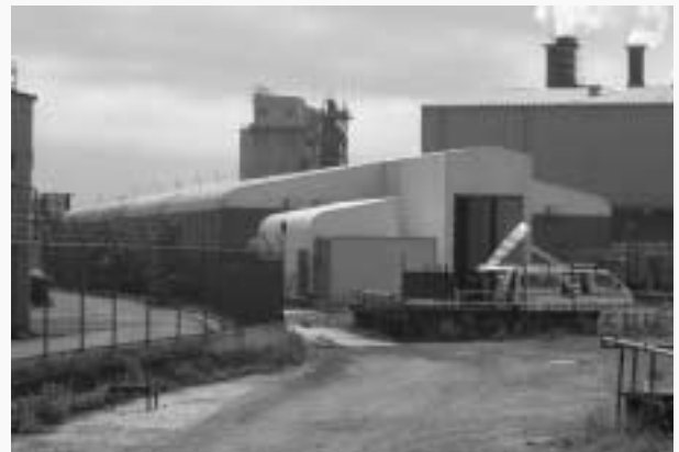
テント設置状況(橋脚工事現場)
