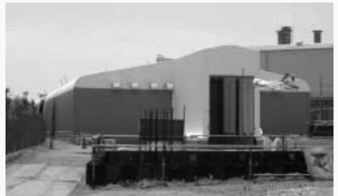
橋脚工事現場のテント(P29～P30区間)の状況
