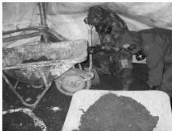
掘削調査の状況
