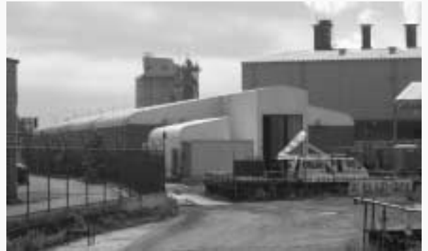
橋脚工事現場のテント設置状況
