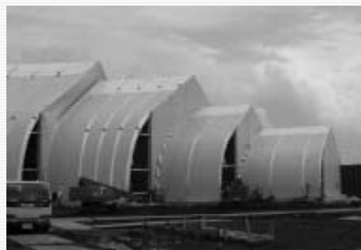
テント施工状況
