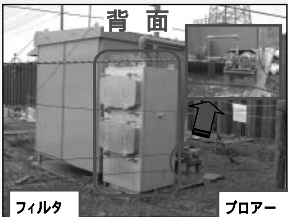
空気浄化機能を持った密閉型保管庫 (掘削残土仮置き場と橋脚工事現場)
