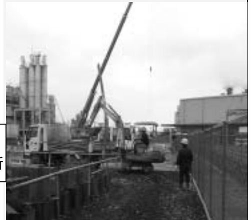
仮囲い作業状況
