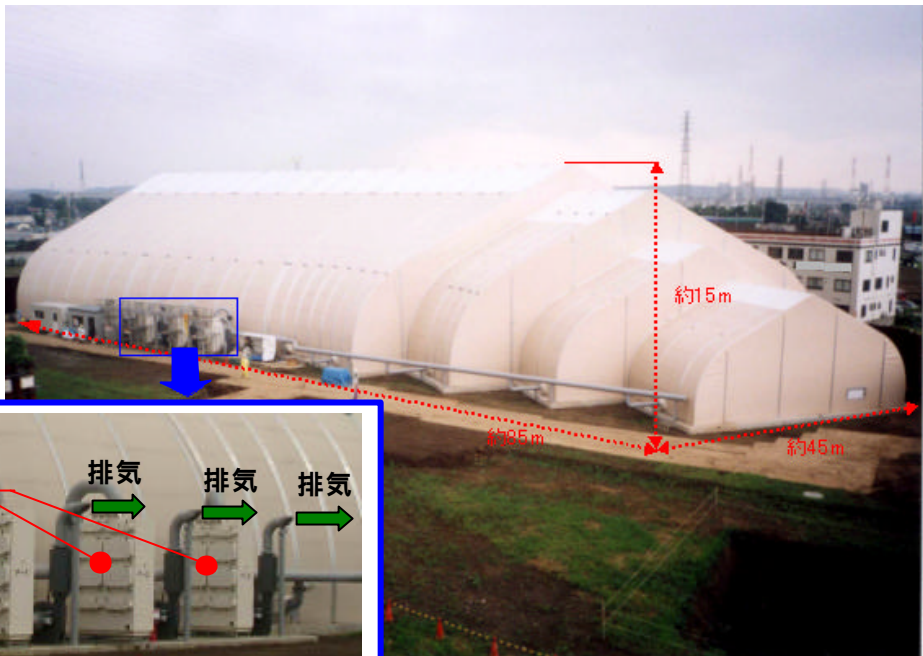
テント配置図（残土仮置き場：田端大テント）
