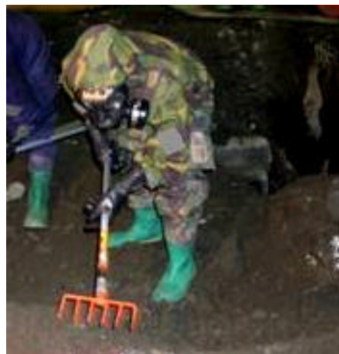
掘削調査の状況
