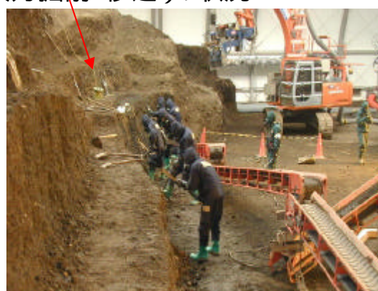
分離作業 (機械掘削・吸引+人力掘削・移送)の状況
