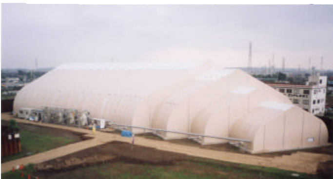
掘削残土仮置き場 テント
