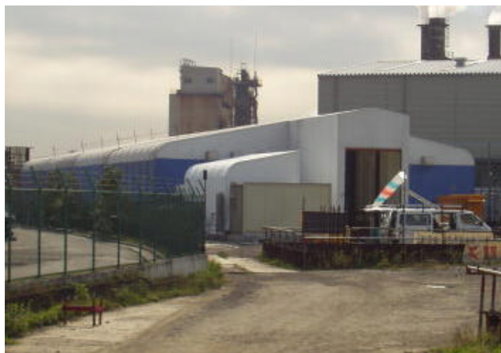
テント設置状況（北側ブロック） 南側ブロックに移設
