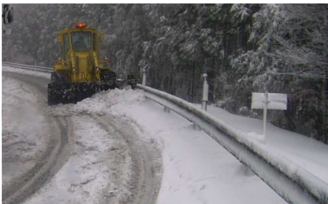
▲箱根新道における除雪作業
