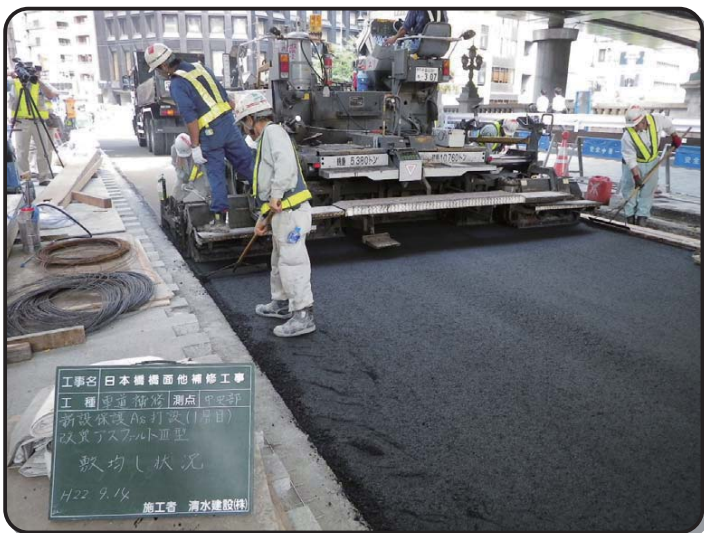
ぼうすいほごそう ▲防水保護層（アスファルト）の設置状況
