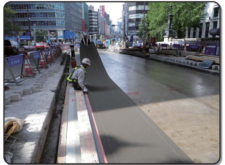
▲防水シートの設置状況
