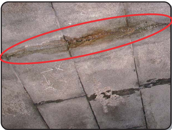
▲橋面の裏から色水のしみ出す様子が確認
