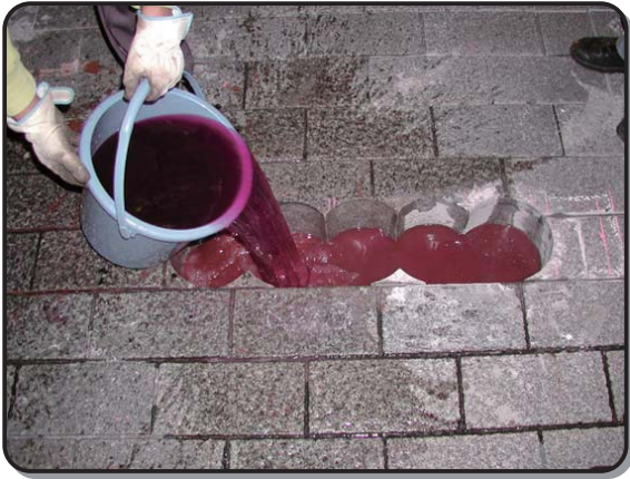
▲橋の表面から色水を流し入れ、水の流動を調査
