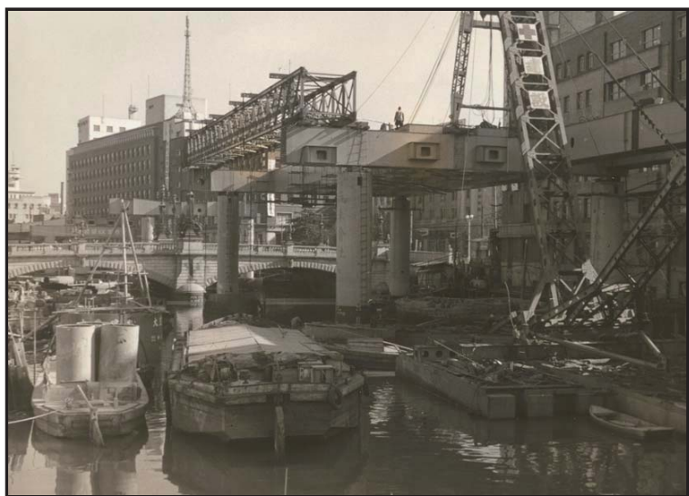
▲首都高速道路建設 1962（昭和 37）年頃撮影 東京都中央区立京橋図書館所蔵
