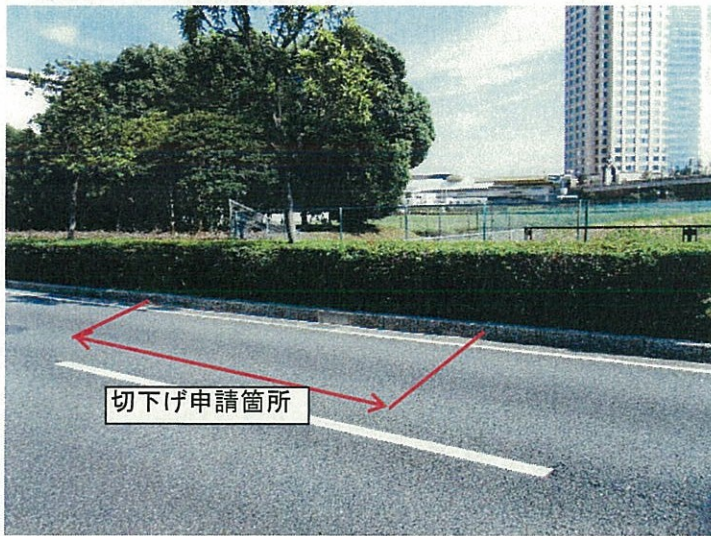
国道357号線 歩道部
