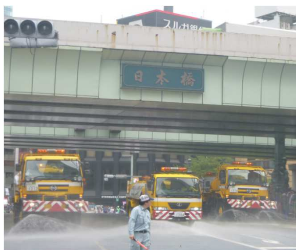
橋洗い、散水車(3台)による洗浄です 今年も再生水で実施しました
