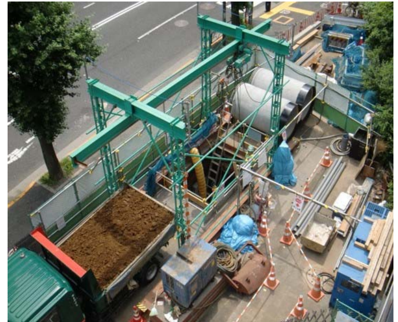
推進発進立坑
