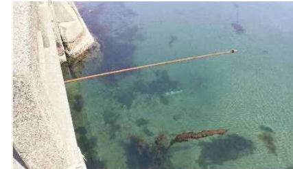
(海側) PC鋼棒 φ23, L=3m突出
