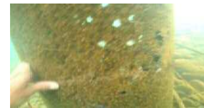
鋼管の腐食状況
