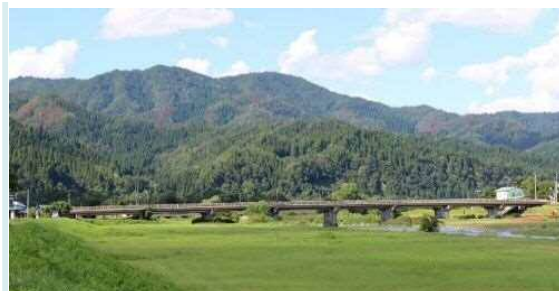
<万石橋の状況>
