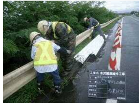
<防護柵の取替>
