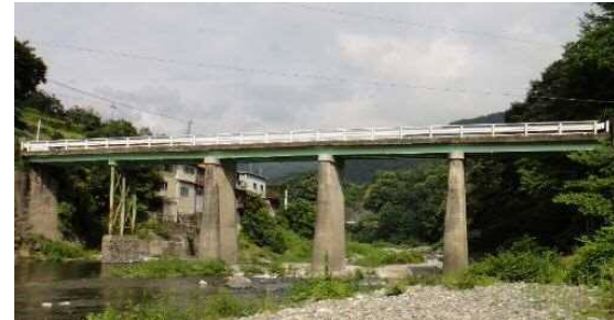
<御鉾橋の状況>
