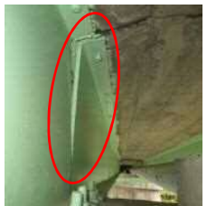
主桁の変形
