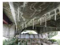
主桁のひびわれ
