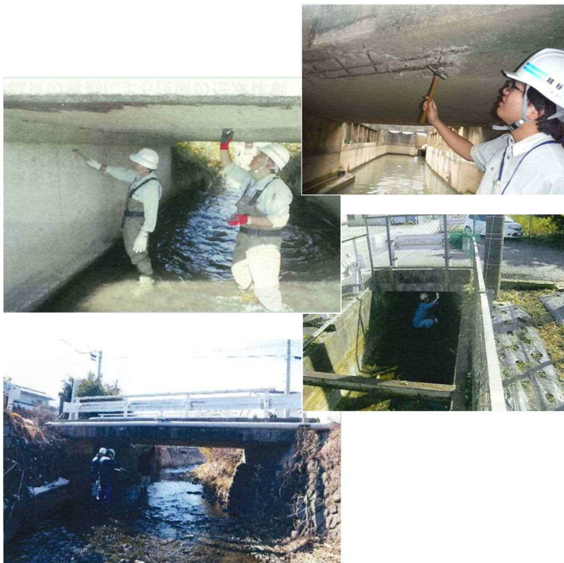
直営点検の主な実施状況
