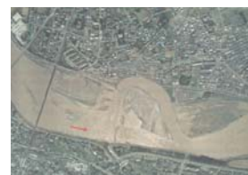
▲台風16号による決壊直後の多摩川(狛江地区)
