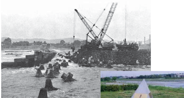
▲破堤した堰の仮堤防工事
