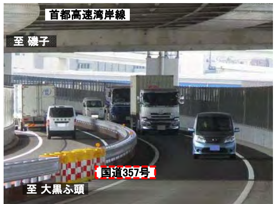
写真④: 高架橋部
