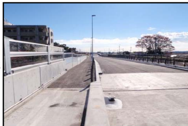
写真② 歩道が整備されたバイパス (整備後)
