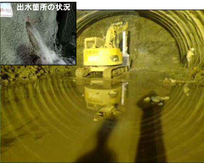
■トンネル坑内の冠水の状況(上八木沢トンネル) かみやぎさわ
