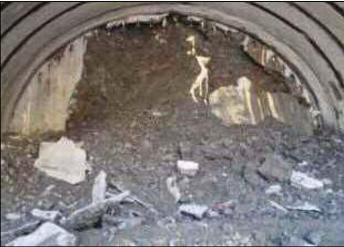
■地盤の膨張によりトンネル断面が圧縮され、掘削後の断面に変形が生じ、下面に亀裂が発生(城山トンネル)<sup>しろやま</sup>
