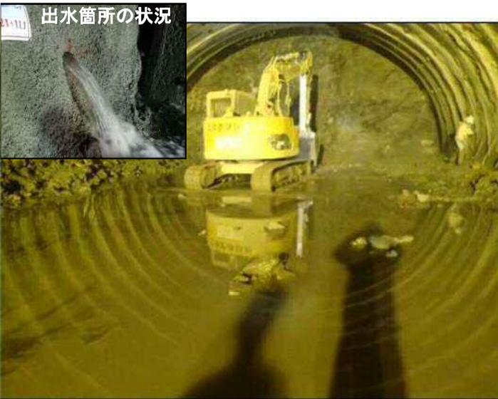
■トンネル坑内の冠水の状況(楮根第4トンネル)<sup>かぞね</sup>
