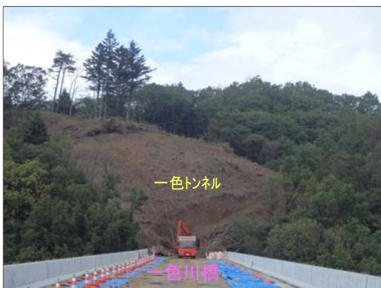
いっしき ⑱ 一色川橋
