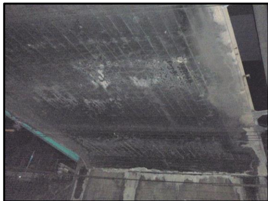
主桁の損傷 (遊離石灰)
