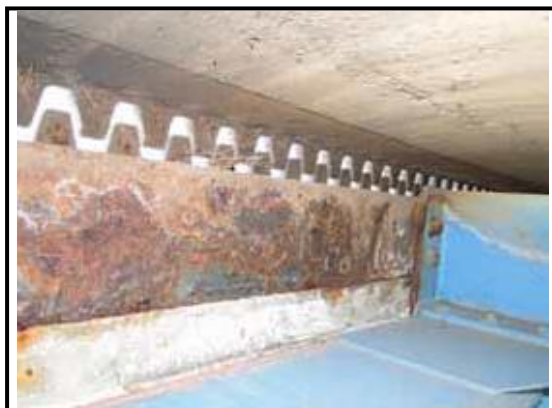
伸縮装置の腐食状況
