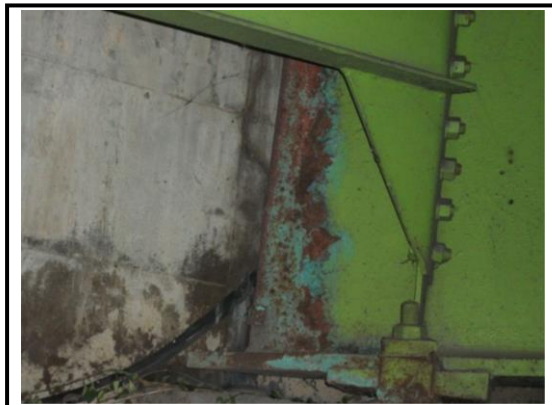
主桁・横桁の損傷
