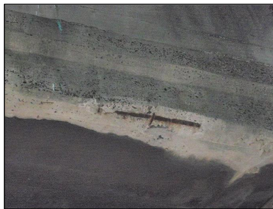
主桁の損傷 (鉄筋露出)
