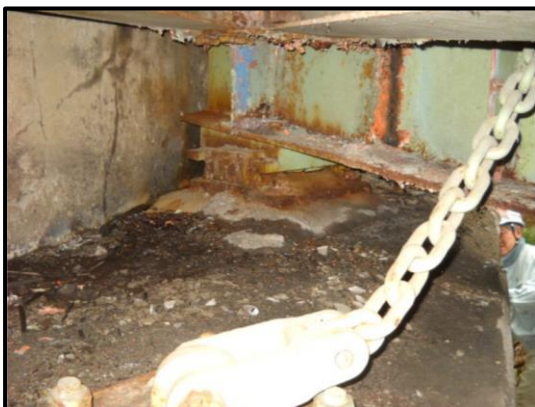
主桁・支承の損傷
