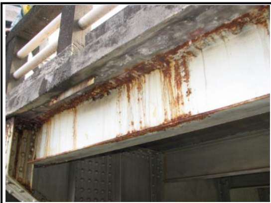
主桁・横桁の損傷
