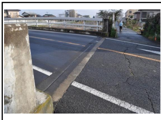
伸縮装置の損傷
