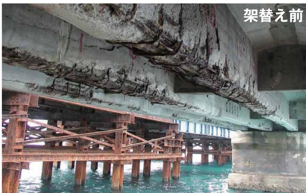
橋桁の中の鋼材が腐食し、コンクリートが剥がれ落ちた橋
