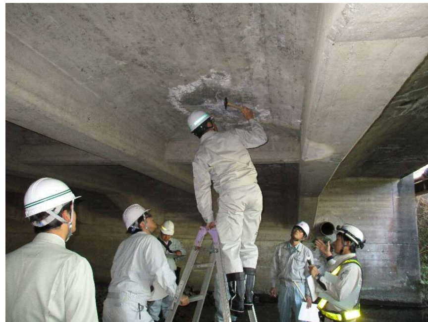
橋梁点検実技研修（新陽橋）
