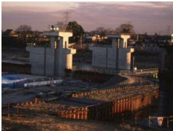
①六堰改築工事
