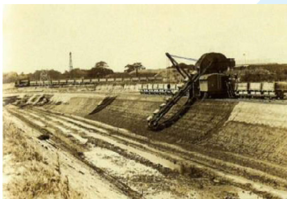
機械動力による施工
