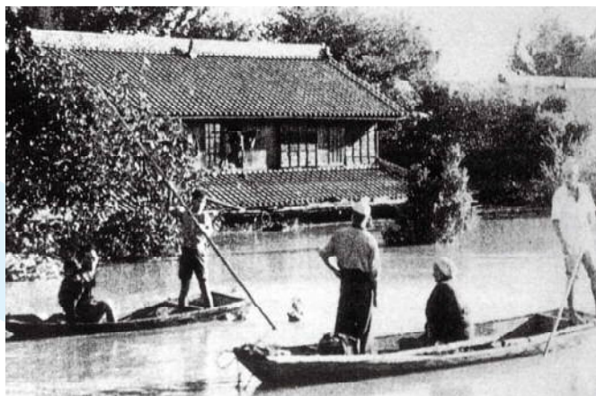
カスリーン台風による古谷村の浸水状況（現川越市） 出典：埼玉新聞社
