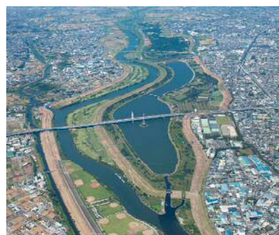
荒川第一調節池
