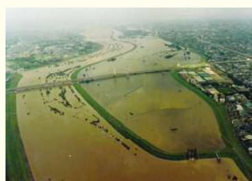
洪水をためる荒川第一調節池
