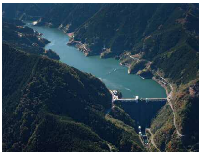
浦山ダム 1999(平成11)年完成
