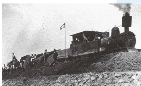
蒸気機関車による土運搬の様子
