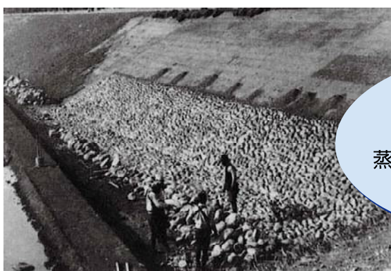
人力による施工
