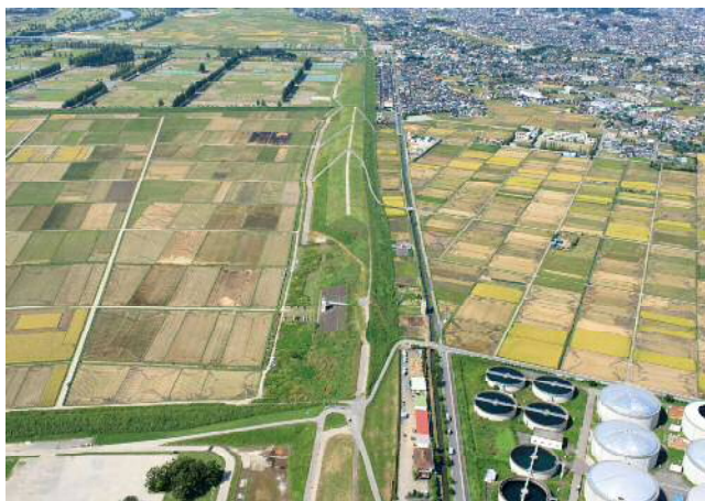
さいたま築堤左岸 (39.2k)
