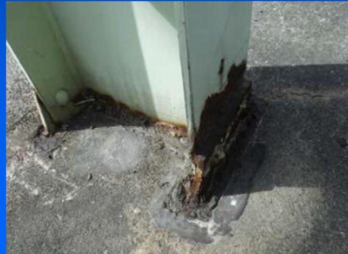
埋め込み部材の著しい局部腐食
