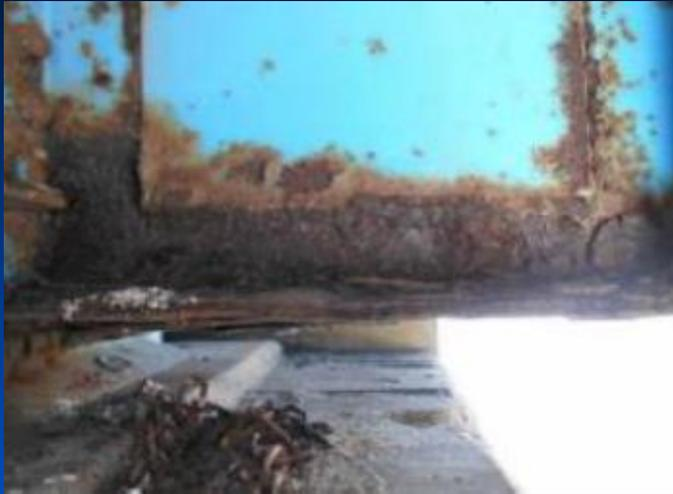
主桁端部の腐食断面欠損
