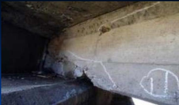
単純RC桁端部の崩壊
