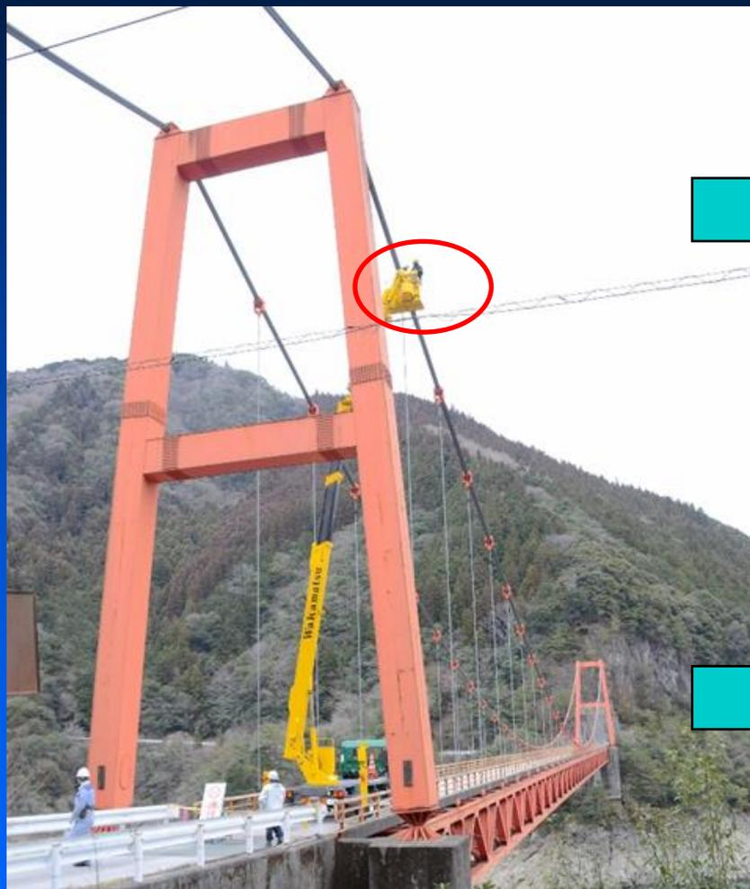
高所作業車で近接目視点検を行い、主ケーブルの破断を発見
