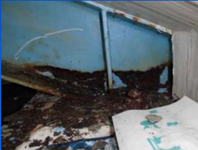
主桁端部の腐食断面欠損
