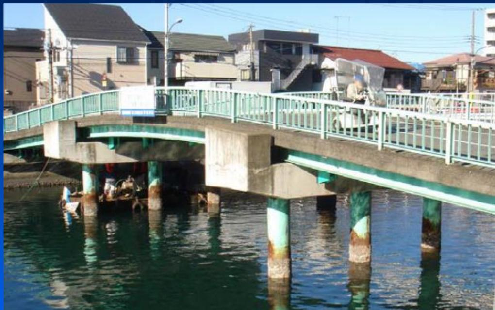
汽水域では、水中で鋼部材に激しい局部腐食が生じることがある
