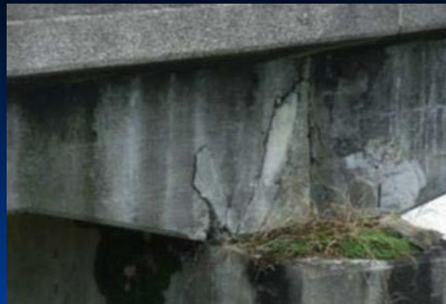
主桁支点部のせん断破壊
