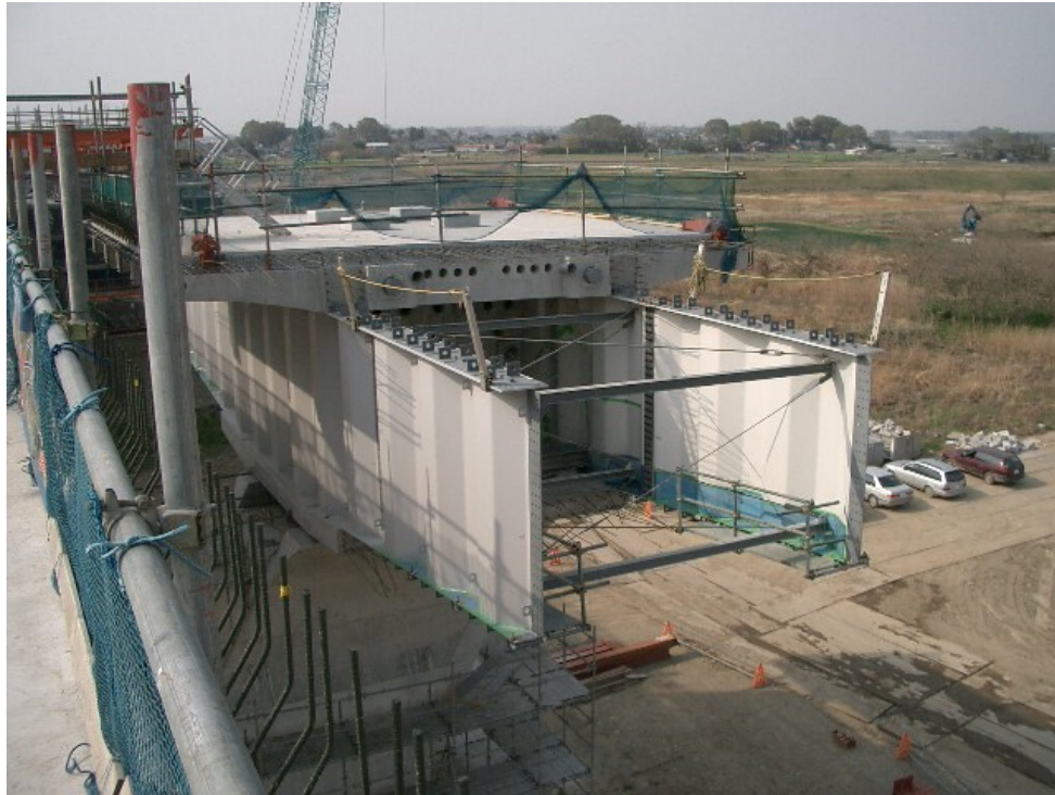
波形鋼板ウェブ橋
