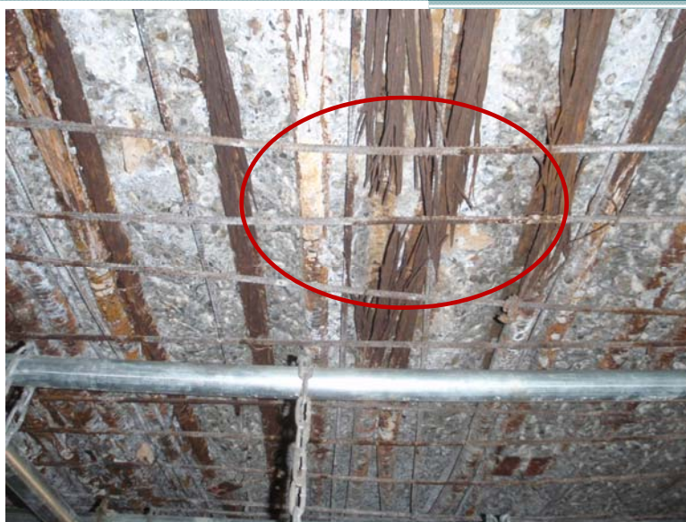
箱桁下床版におけるPC鋼材の破断
