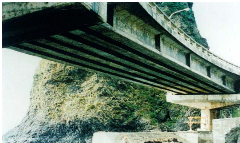
桁下面に錆び汁(15年経過)
