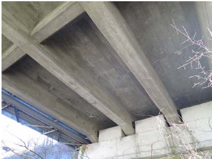
鉄筋コンクリート桁 ■ 損傷は見られず
