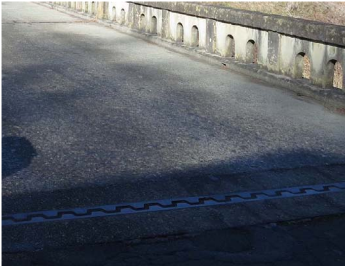
コンクリート舗装 ■ひび割れ
