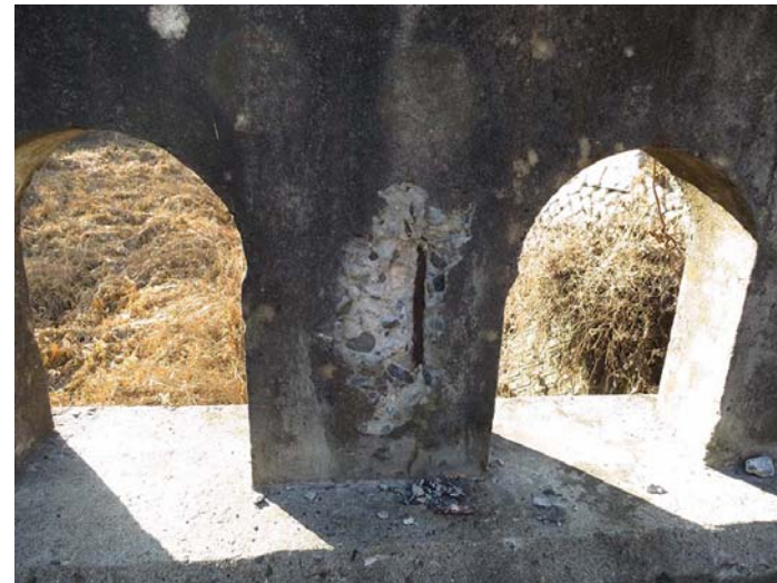
高欄 ■コンクリート剥落 ■鋼材腐食
