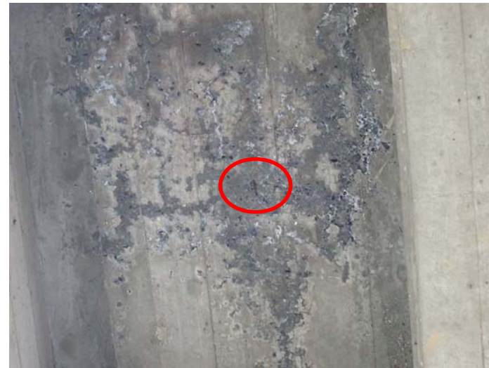
鉄筋コンクリート床版 ■ コンクリート剥離 ■ 鋼材腐食
