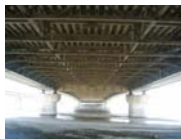
高所作業車で近接できない
