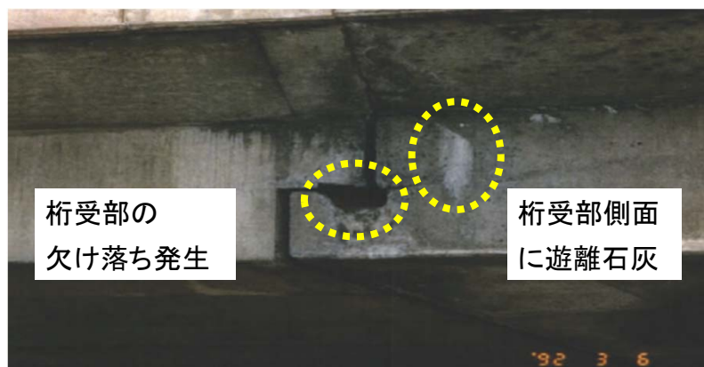
桁受部の状況(1992年)
