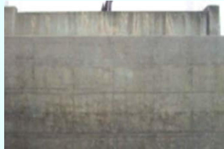
断面修復した橋台の再劣化
