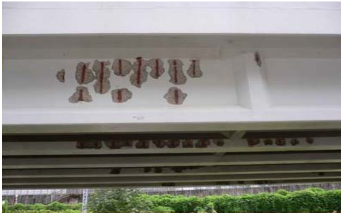
保護塗装の剥離、鉄筋露出
