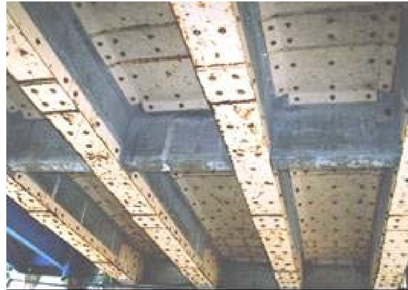
接着された鋼板が剥離。鋼板そのものも腐食。
