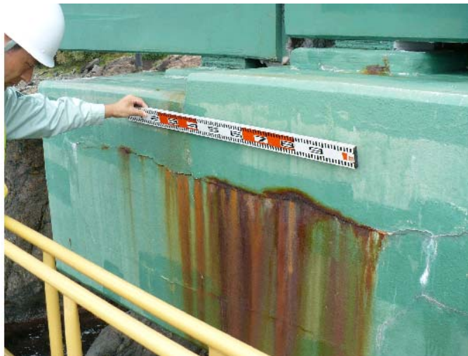
保護塗装のひび割れ
