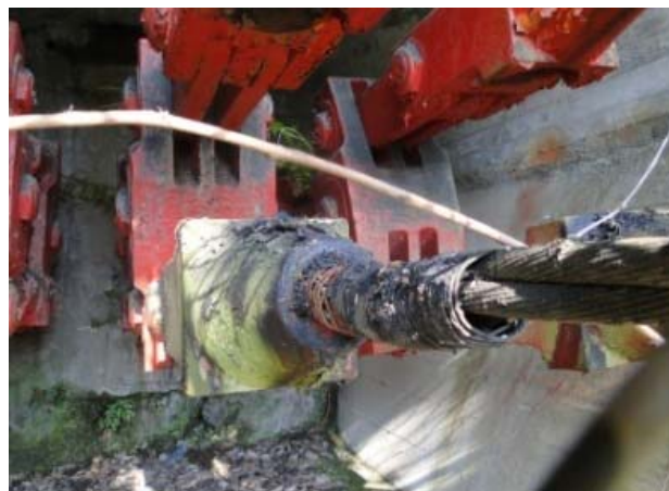
ケーブル定着部
