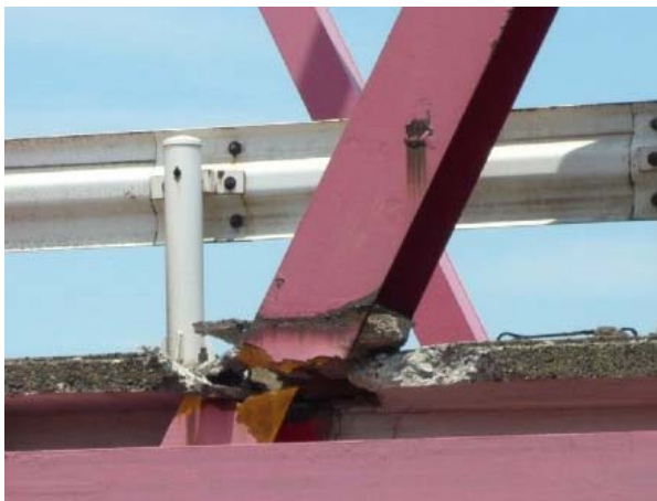
コンクリート埋込部
