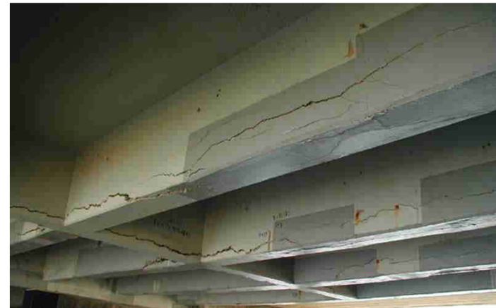
断面補修部のひび割れ
