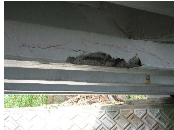
断面補修部の剥落
