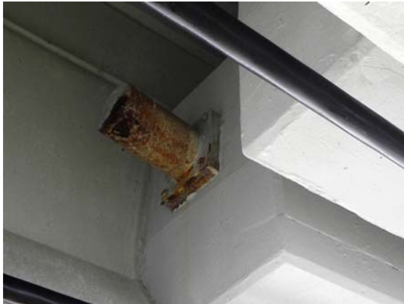
補強により追加した外ケーブル 定着部の劣化
