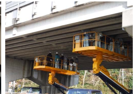
近接目視点検の状況
