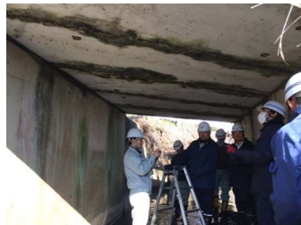
合同点検の状況
