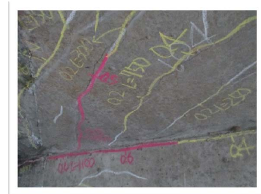
<ひび割れの様子>
