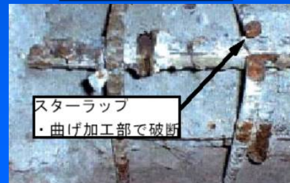
コンクリートはつり調査
