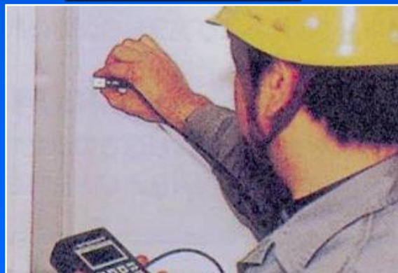
鋼部材の超音波探傷
