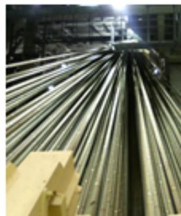
→ 主ケーブルの水平張力の全てを負担する特に重要な構造物であるが、定着部や構造本体が地盤に埋め込まれている場合があるなど点検しにくい場所にある場合がある。
