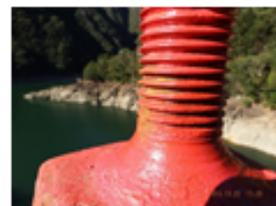
→鋼製ロッドでは、長さ(張力)調節などのために、ねじ部のあることが多く、応力集中による亀裂が生じやすい
