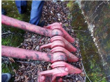
図-6 屋外に暴露されている定着部の例
