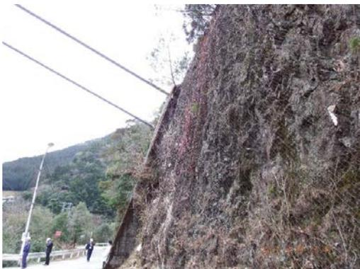
図-7 地山に埋設されたケーブル定着部
