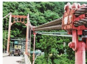
写真-4 セーフティケーブル設置状況
