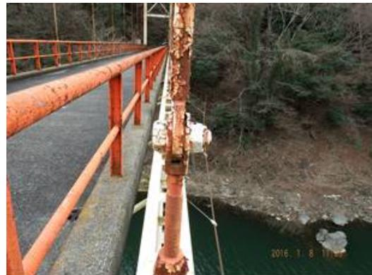
図－3 耐風索の例（桁の右横に見える細い索が耐風索）
