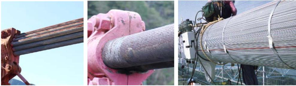
図-12 ケーブルの例（より線ワイヤー、ロックドコイル、平行線）
