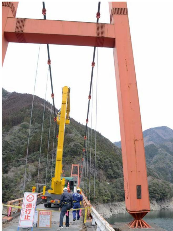
図-8 基部がピン構造の塔の例
