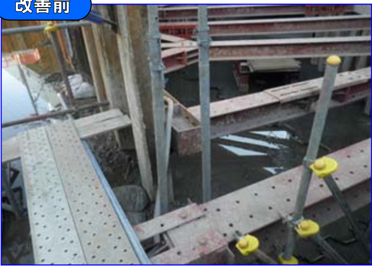
開口部に養生が無く、転落の危険がある
