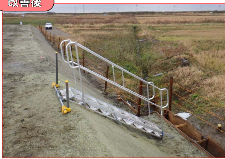
単管パイプで固定された、手すり付きの昇降設備を設置
