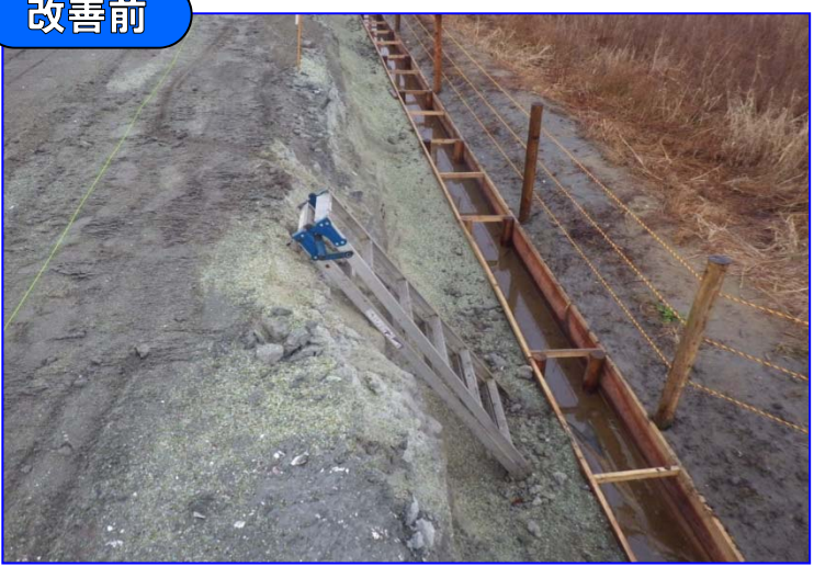
固定措置をしていない脚立を梯子代わりに使用しており、転落の危険がある。
