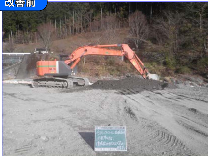
重機の作業半径が明示されていない
