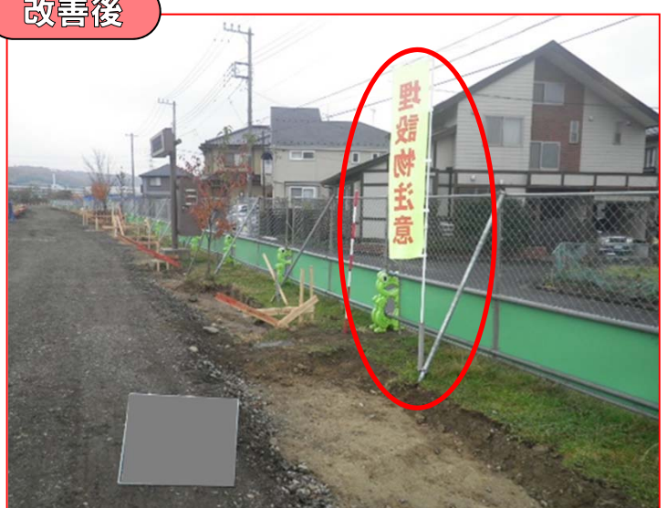
のぼり旗を設置し、埋設物に対する注意を促す
