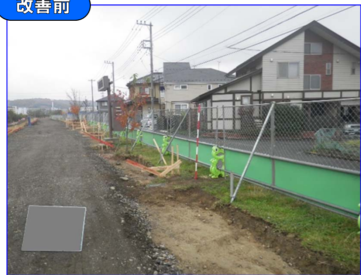
埋設物の有無が示されていない
