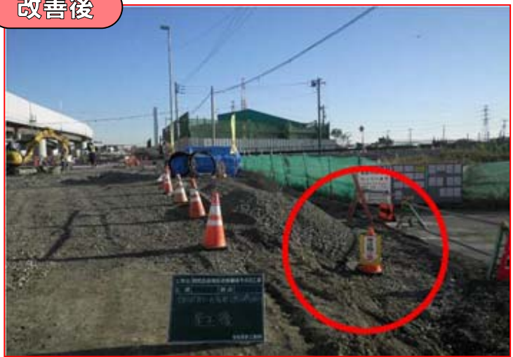
カラーコーンと表示板で埋設物の位置を明示
