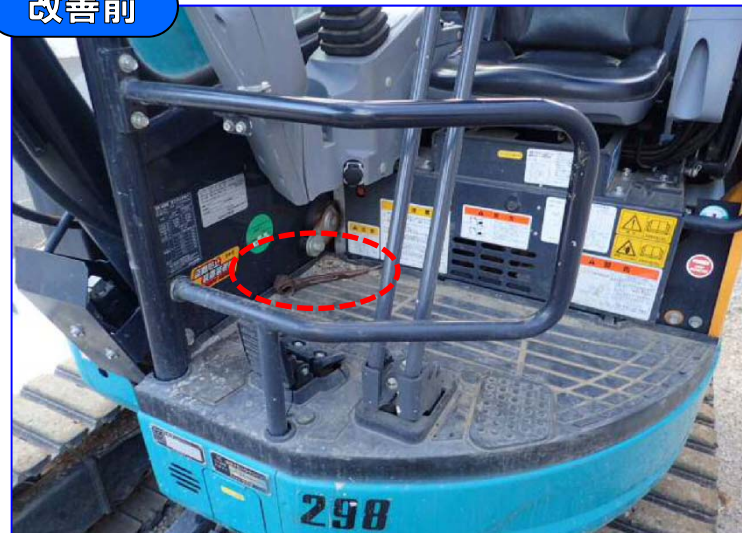
バックホウの運転席に工具が置かれており、ペダルの誤操作、オペレーターの転倒の危険がある
