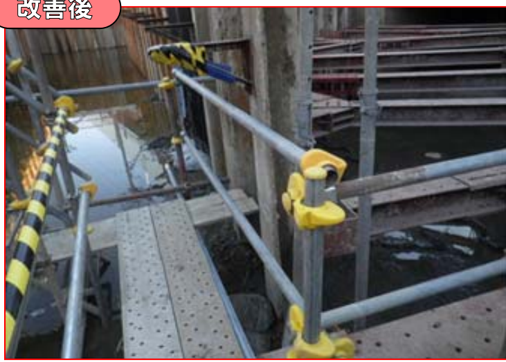
単管パイプで転落防止柵を設置
