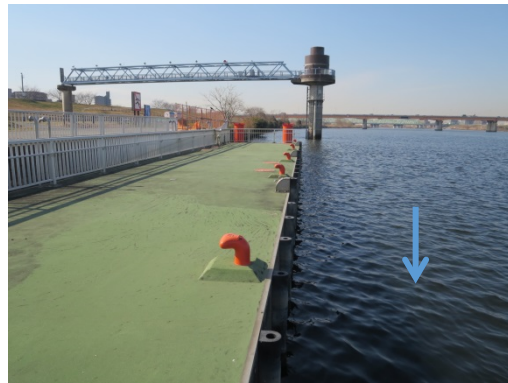
4. 岩淵緊急用船着場
