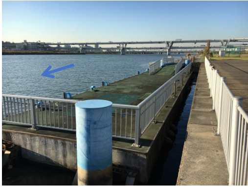
9. 堀切緊急用船着場
