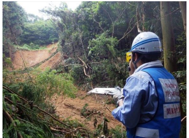
土砂崩れの幅等を計測
