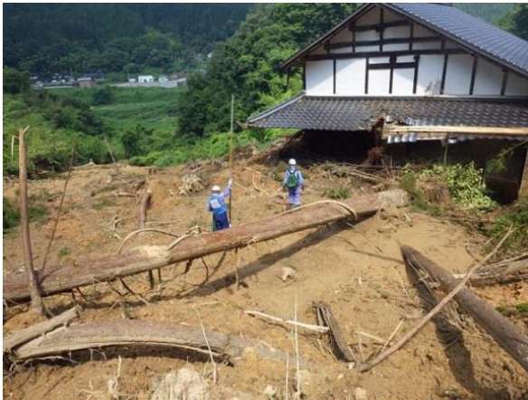
住宅へ土砂が流入
