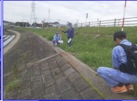
坂川の点検状況
